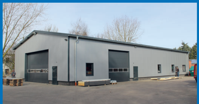
Der Firmensitz der Kraft Curing Systems GmbH in Lindern ist um einen 450 m 2 großen Hallenneubau gewachsen.
