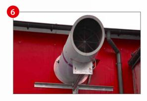
Unsere selbst gefertigte, elektrisch angetriebene Absaugung senkt die Luftfeuchtigkeit.
