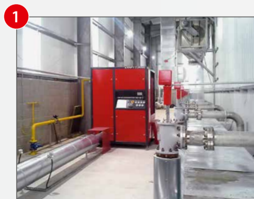
Der Dampferzeuger spart zwischen 40% und 60% der Betriebskosten im Vergleich zu Dampfkesseln. Der direkt befeuerte Dampferzeuger arbeitet mit Erdgas oder Dieseldieselkraftstoff, mit Niederdruck und steht auf einer kleinen Stellfläche.
