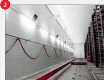
우리의 기술 덕분에 온도 40°C 에 습도가 90%에서도 양생실안 습기 안개에 응축 물이 방지됩니다. 이렇게 하면 센서 (광 센서 또는 레이저 센서) 는 정상 작동이 되며 철 구조물은 영향을 받지 않습니다.
