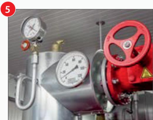
ThermalCure® 시스템은 80 ° C ~ 110 ° C도의 수온으로 50 ° C ~ 70 ° C의 최대 콘크리트 온도에 도달합니다.
