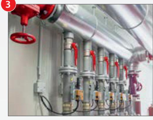
열 분배 시스템은 금형을 독립적으로 가열 할 수 있습니다. 그림은 자동 차단 밸브와 온도 표시가 있는 분배기를 보여줍니다. 자동 밸브 앞 또는 뒤에 수동 차단 밸브가 있어 빠르고 쉽게 유지 보수가 가능합니다.
